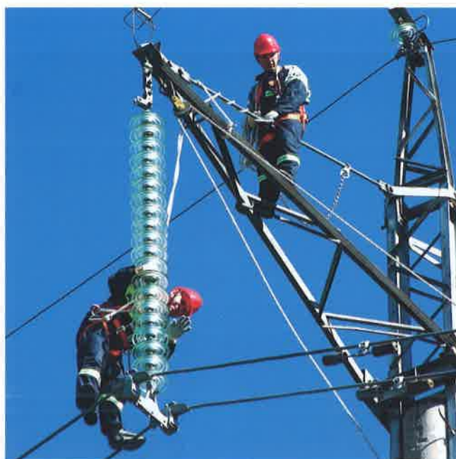
Монтаж опоры ВЛ 330 кВ
